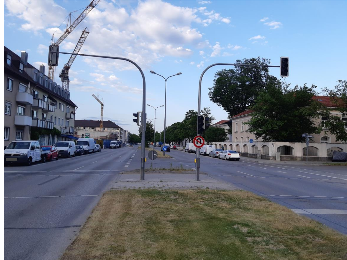
Fußgängerschutzanlage Stadelheimer Straße
