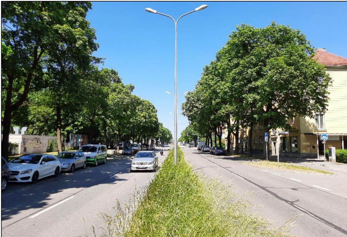
Foto: LHM, „Höhe Stengelstraße Blick Richtung Norden“
